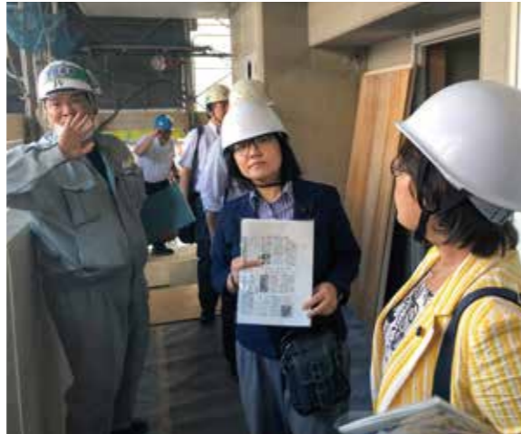
▲県営住宅建設現場視察
